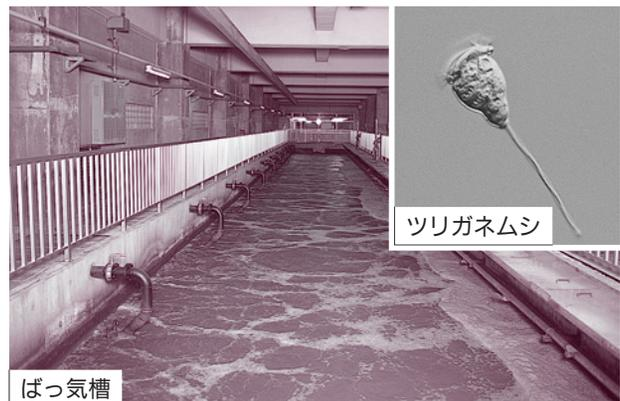
ばっ気槽では、微生物を含む活性汚泥を処理水に加えて、空気を大量に吹きこんでいる。微生物は、川の中と同様に、空気から酸素を取りこんで有機物を分解する。空気を吹きこむのは、その分解効率を上げるためである。
